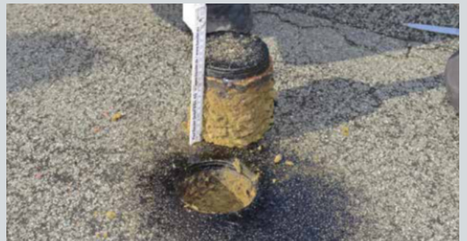
Pilt17/2: Katusekonstruktsioon avatakse kuni aurutõkkeni. Kontrollitakse eemaldatud soojusisolatsiooni ja seejärel suletakse avatud ala uuesti professionaalselt.
